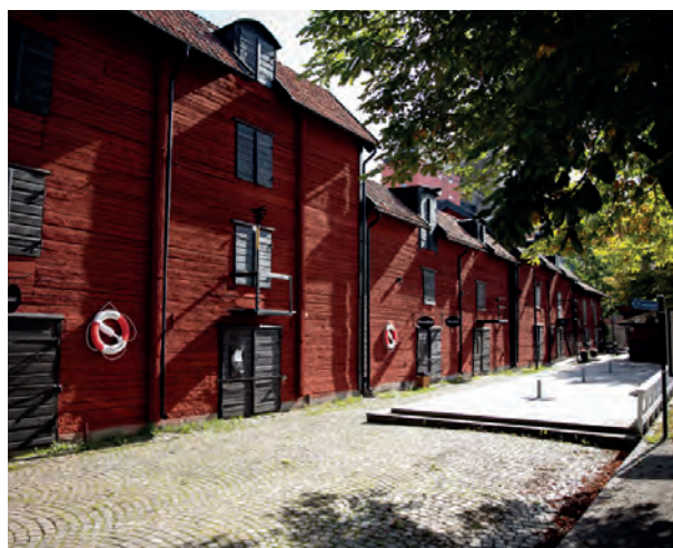
Hamnmagasinen. Foto: Enköpings kommun.
