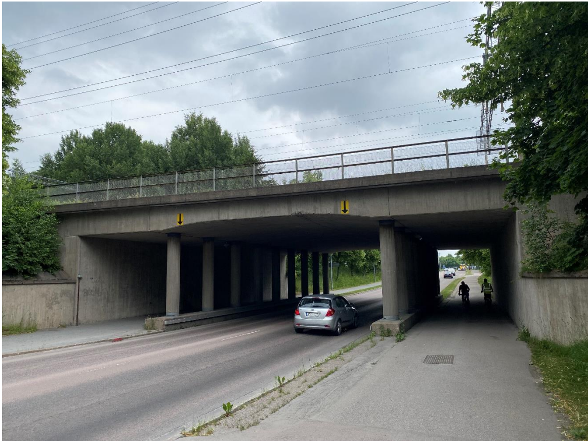
Figur 35. GC-tunneln längs Salavägen.
