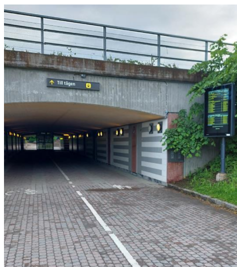
Figur 34. GC-tunneln vid stationen.
