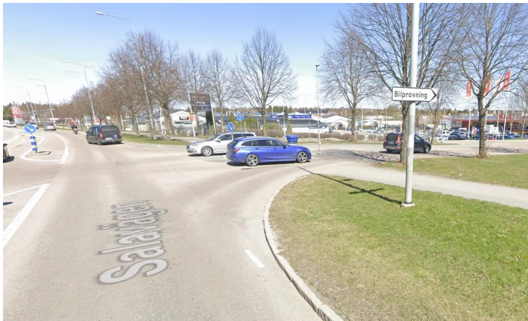
Figur 1-3 Salavägens parallella GC-väg saknar både reglering och upphöjda passager där bilvägen korsar GC-vägen. Utformningen missgynnar framkomlighet och trygghet för fotgängare och cyklister. Korningen är lokaliserad ca 400 meter norr om stationsstaden. Foto: Google Street View
