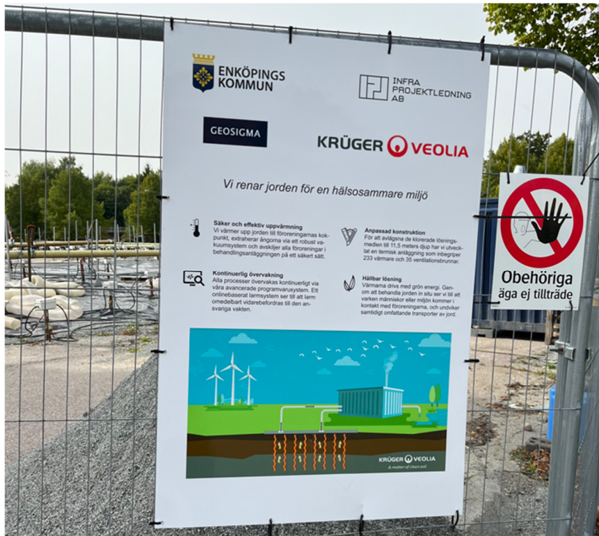
Figur 3.3 Platsen där kemitvåtsbyggnaden stått där åtgärder för termisk behandling har installerats, hösten 2023.
