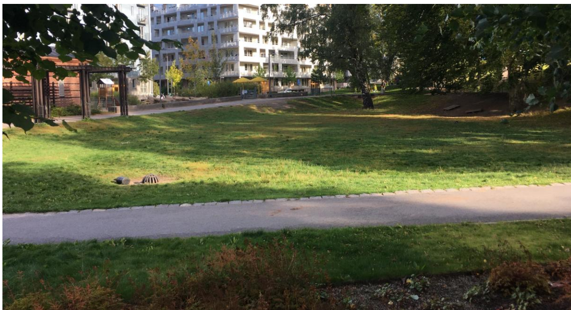
Figur 18. En tydligt nedsänkt gräsyta med bräddbrunn i Norra Djurgårdsskogen. Foto: WRS.
