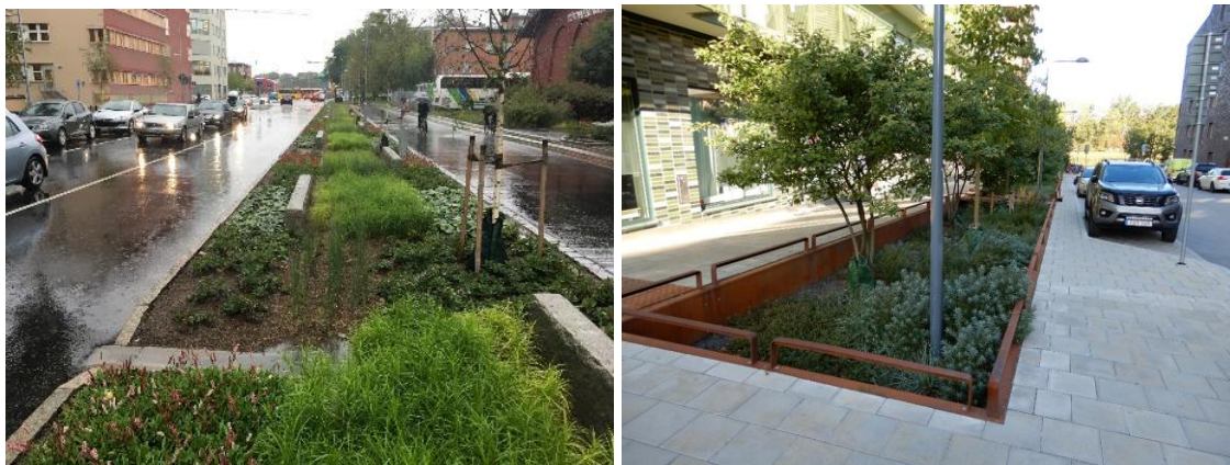
Figur 25. T.v: Exempel på utformning av nedsänkta regnbäddar med trädplantering i anslutning till gata, gång- och cykelväg i Uppsala. T.h: Nedsänkt regnbädd i Norra Djurgårdsstaden i Stockholm. Foto: WRS.
