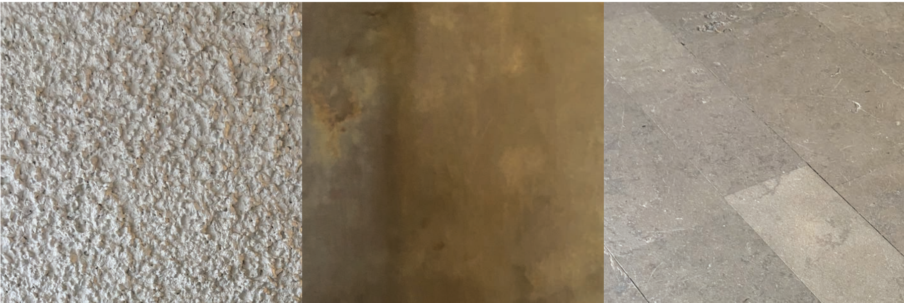
Invändig spritputs, mässingspelare och kalkstensgolv från foajé i huvudbyggnaden
