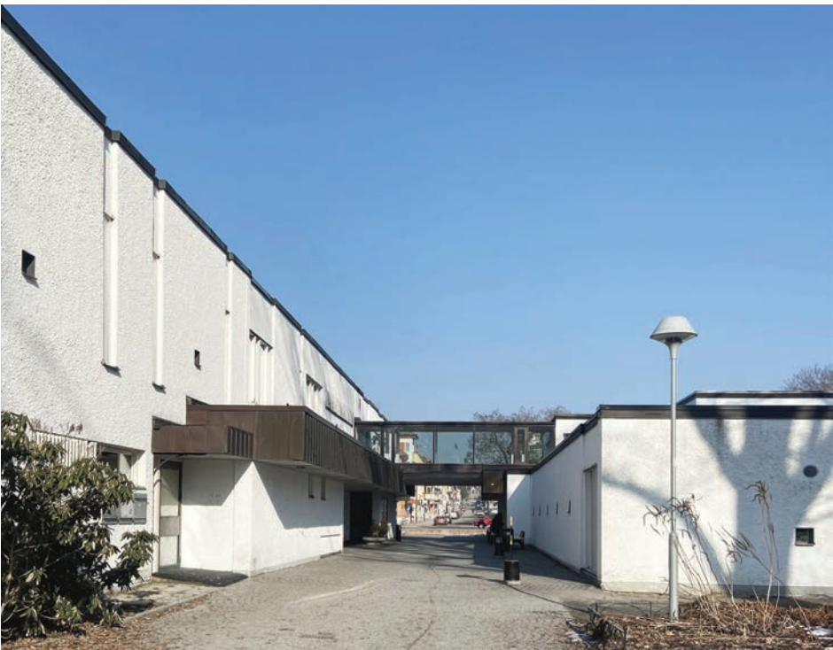
Vy genom passage mellan huvudbyggnad och biblioteksbyggnad, mot centrum.
